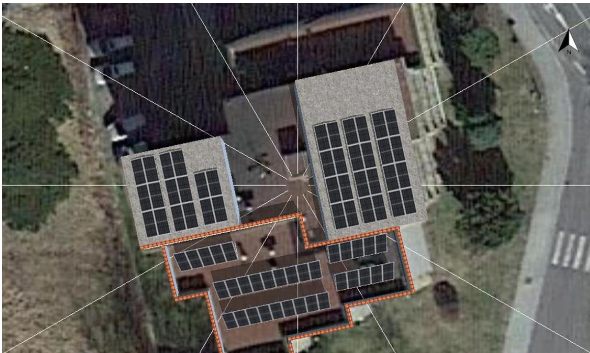
Obrázek 18 Instalace FVE na bytový dům č.p. 181
