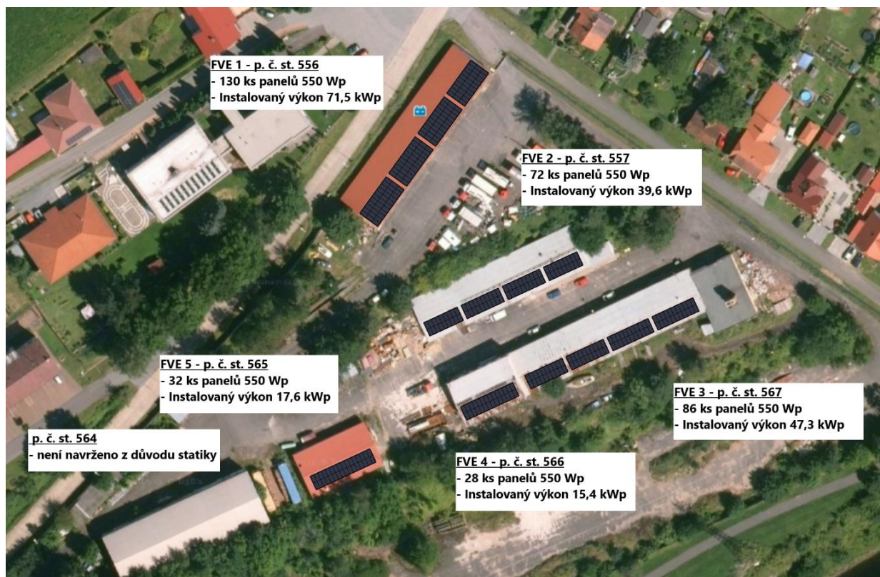
Obrázek 19 Instalace FVE na objekty autoparku
